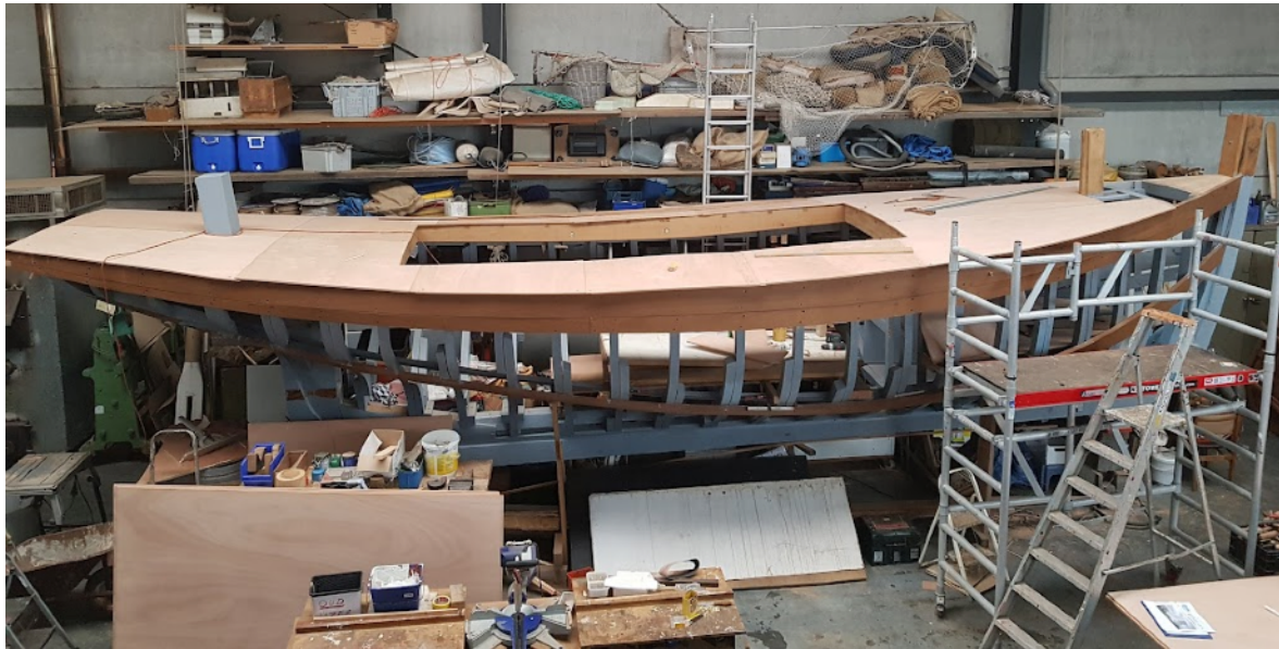
Verdere afbouw van de Sainte Yvonne een project voor de volgende jaren
